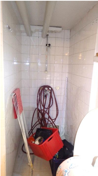
Kuvat 56 a ja b. Lastentalon siiven kellarikerroksessa oleva suihkutila. Seinälaattoja irti ja väliseinä ”pullistaa”.
