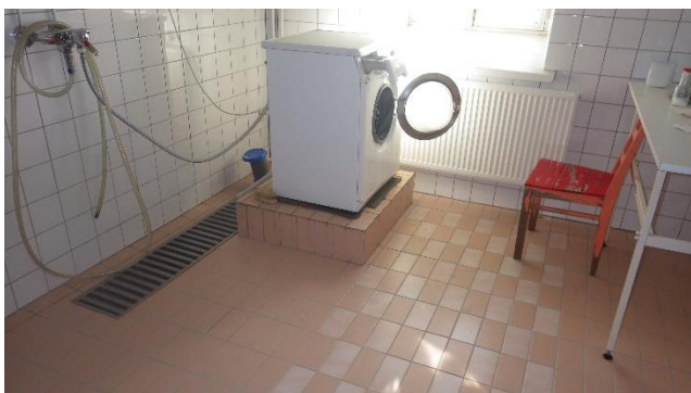
Kuvat 43 a ja b. Asuntosiiven kellarikerroksen pesutupa (Tila 028). Pinnoissa todettiin koholla olevia pintakosteusilmaisimen lukemia.
