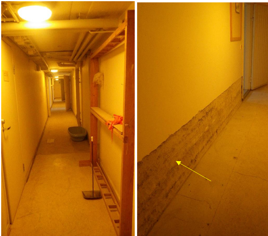
Kuvat 14 a ja b. a) Lastentalon kellarin kantava väliseinälinja käytävän kohdalla. b) Kantavan seinälinjan maali-/ rappaus on poistettu aiemmin kellarikerroksessa olevien kosteusongelmien takia. Tutkimusten aikana seinälinjasta ei havaittu näissä kohdin kohonneita pintakosteusilmaisimen arvoja. Pinnoitteet on poistettu seinien alaosista jo useampia vuosia sitten.
