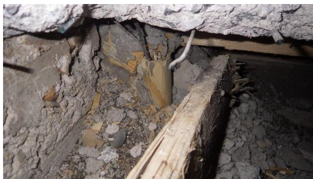
Kuvat 29 a ja b. a) Rakennusaukko RA-VP1 tilassa 105. b) Muottilaudat osin paikoillaan. Eristeenä on käytetty koksikuonaa.
