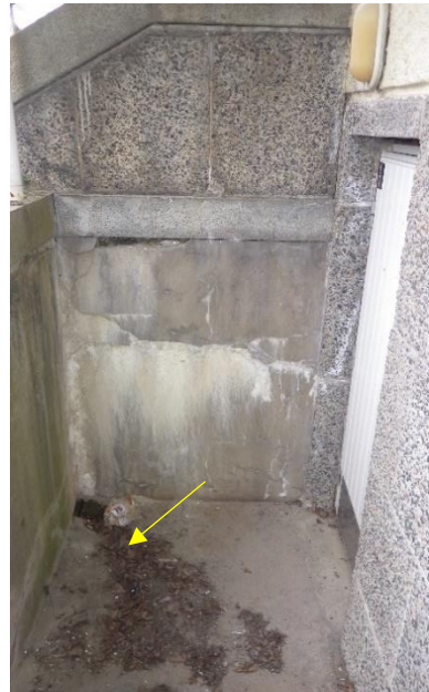
Kuvat 6 a-c. a) Lastentalon pohjoisseinustan sisääntulon kohdalla katolta tulevat sadevedet ohjataan portaikon vierustoille. b) Kellarikerrokseen johtavan luiskan seinämässä on runsaasti kosteuden aiheuttamaa kalkkihärmää. Luiskan alatasanteen sadevesikaivon vedenpoistossa ongelmia. c) Keittiön sisäänkäynnin vieressä katolta tulevat sadevedet lasketaan suoraan maahan.
