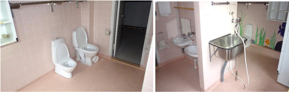
Kuvat 58 a ja b. Yleiskuva päiväkodin käytössä olleesta wc-tilasta (tila 115). Ei poikkeavia pintakosteusilmaisimen lukemia lattiassa tai seinissä.
