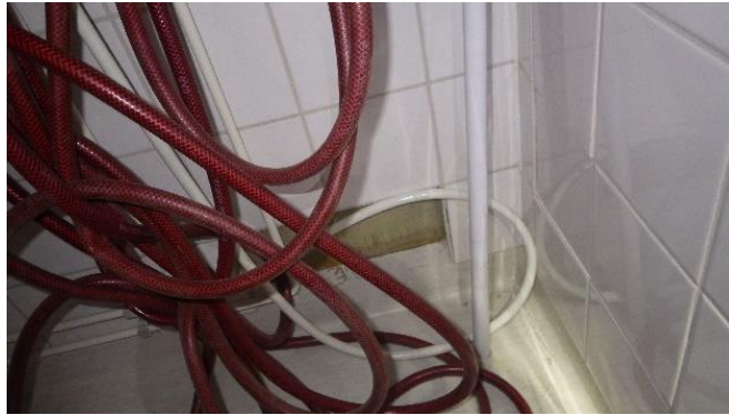
Kuvat 56 a ja b. Lastentalon siiven kellarikerroksessa oleva suihkutila. Seinälaattoja irti ja väliseinä ”pullistaa”.
