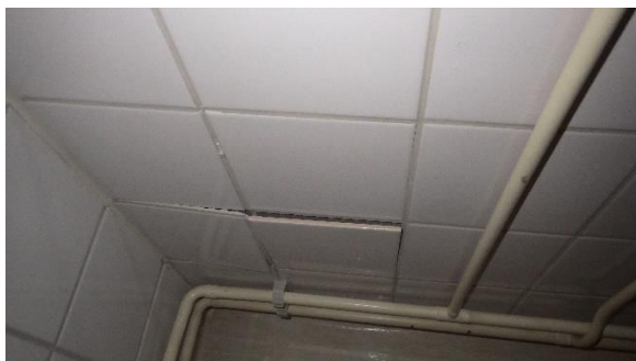
Kuva 55 a ja b. Yleiskuva tilasta 011. Seinälaattoja irti tai irtoamassa seinästä.
