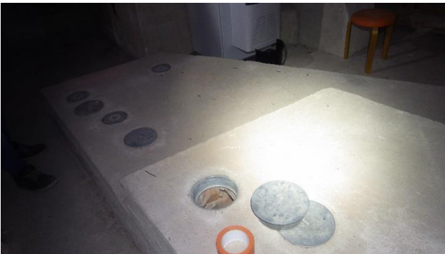
Kuvat 37 a ja b. a) Rakennusmateriaaleja ilmavaihtokanavia ullakkotilassa. Tarkastusluukusta tarkasteluna kanavissa oli voimakasta ilmavirtausta. b) Pystyhormi tarkastusluukusta tarkasteluna.
