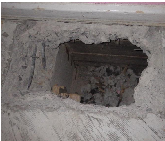
Kuvat 30 a-c. a) Rakennusaukko RA-VP2 palkin ja ulkoseinän liittymäkohdassa. b) Täyttökerroksen paksuus vaihtelee paikoittain. Täytön seassa tiilen kappaleita ja laastipursetta. c) Muottilaudat kiinni palkin kyljessä.
