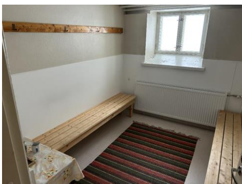
Kuvat 44 a ja b. Asuntosiiven kellarikerroksen pukuhuone (Tila 033). Lattia- ja seinäpinnoissa todettiin normaalista poikkeavia pintakosteusilmaisimen lukemia. Mm. seinien alaosien pintoja on korjattu jo aiemmin kosteusongelmien takia.
