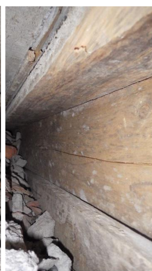
Kuvat 30 a-c. a) Rakennusaukko RA-VP2 palkin ja ulkoseinän liittymäkohdassa. b) Täyttökerroksen paksuus vaihtelee paikoittain. Täytön seassa tiilen kappaleita ja laastipursetta. c) Muottilaudat kiinni palkin kyljessä.
