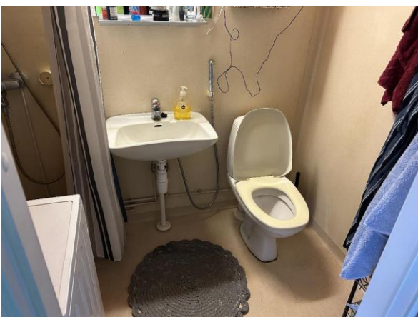
Kuvat 50 a ja b. Asunnon 3 kylpyhuone. Wc-istuimen ympärillä todettiin pienellä alueella pintakosteusilmaisimella poikkeavia lukemia, mutta muuten rakenteiden pinnoissa ei todettu pintakosteuskartoituksessa poikkeavia lukemia niiltä osin, joista kartoitus kylpyhuoneessa voitiin tehdä. Ei rakennekosteuksien takia tarvetta nopean aikataulun korjauksille.
