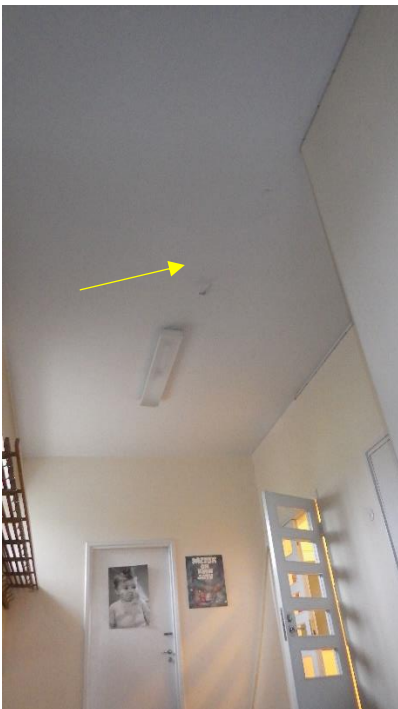
Kuvat 34 a ja b. a) Eteisaulan 140 katossa vanha, mahdollisesti kosteuteen viittaava jälki. Tutkimushetkellä pintakosteusilmaisimella ei havaittu poikkeavia lukemia. b) Lähikuva jäljestä, joka aiheuttanut maalipinnan halkeilua ja kupruilua.
