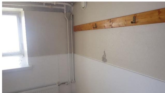
Kuvat 44 a ja b. Asuntosiiven kellarikerroksen pukuhuone (Tila 033). Lattia- ja seinäpinnoissa todettiin normaalista poikkeavia pintakosteusilmaisimen lukemia. Mm. seinien alaosien pintoja on korjattu jo aiemmin kosteusongelmien takia.
