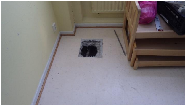
Kuvat 29 a ja b. a) Rakennusaukko RA-VP1 tilassa 105. b) Muottilaudat osin paikoillaan. Eristeenä on käytetty koksikuonaa.
