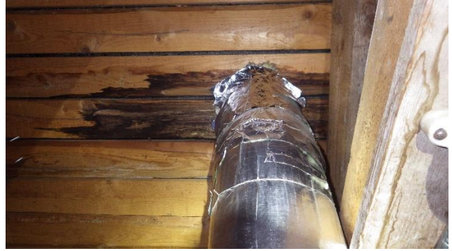
Kuvat 36 a ja b. a) Yleiskuva asuntosiiven ullakosta. Ullakon keskiosalla on vanhoja hormeja sekä rakennusmateriaaleja ilmavaihtokanavia. Ullakkotiloissa on erillisiä varastokoppeja. b) Yksittäisissä kattoläpivienneissä havaittiin vanhoja vuotojälkiä. Piikkikosteusmittarilla kohdat olivat kuivia.
