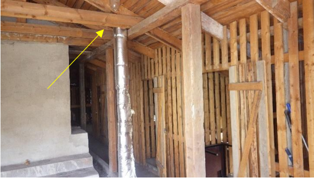
Kuvat 36 a ja b. a) Yleiskuva asuntosiiven ullakosta. Ullakon keskiosalla on vanhoja hormeja sekä rakennusmateriaaleja ilmavaihtokanavia. Ullakkotiloissa on erillisiä varastokoppeja. b) Yksittäisissä kattoläpivienneissä havaittiin vanhoja vuotojälkiä. Piikkikosteusmittarilla kohdat olivat kuivia.
