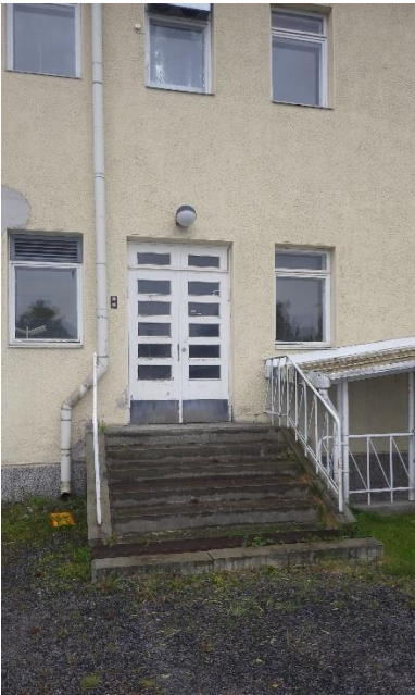
Kuvat 6 a-c. a) Lastentalon pohjoisseinustan sisääntulon kohdalla katolta tulevat sadevedet ohjataan portaikon vierustoille. b) Kellarikerrokseen johtavan luiskan seinämässä on runsaasti kosteuden aiheuttamaa kalkkihärmää. Luiskan alatasanteen sadevesikaivon vedenpoistossa ongelmia. c) Keittiön sisäänkäynnin vieressä katolta tulevat sadevedet lasketaan suoraan maahan.
