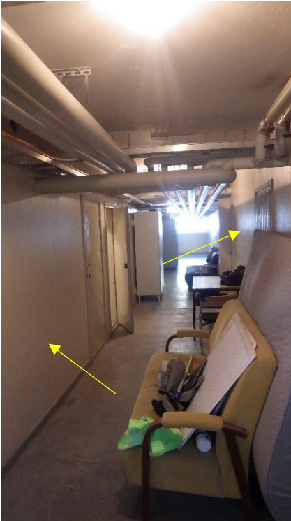
Kuva 16. Kuva asuntosiiven kellarin käytävältä. Kantavissa väliseinälinjojen alaosissa ei havaittu kohonneita pintakosteusilmaisimen arvoja.
