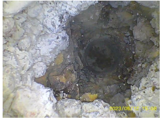
Kuvat 33 a ja b. a) Yleiskuva tilasta 208, mihin tehtiin rakennearaus RA-VP9 poraamalla. b) Poraus kohdistettiin palkin päälle. Endoskoopilla havaittiin palkin päällä olevan 20...30 mm paksu korkkieriste.
