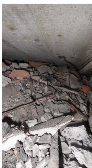
Kuvat 30 a-c. a) Rakennusaukko RA-VP2 palkin ja ulkoseinän liittymäkohdassa. b) Täyttökerroksen paksuus vaihtelee paikoittain. Täytön seassa tiilen kappaleita ja laastipursetta. c) Muottilaudat kiinni palkin kyljessä.
